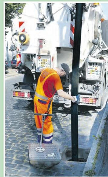
Blätter und Abfall können aber auch durch das Sieb in den Sinkkasten fallen. Der Saugschlauch saugt sie in den Sammeltank des Wagens.
