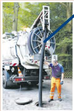
Als Erstes wird die Grube geöffnet. Dann senkt der bewegliche Arm des Wagens den großen Saugschlauch in die Grube.
