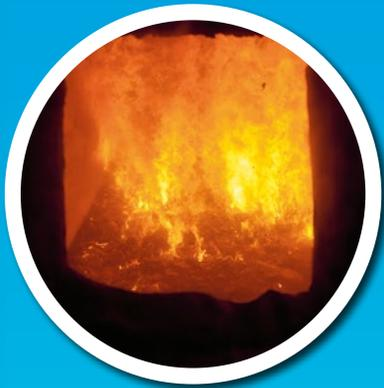
Im **Ofen** wird der Müll bei mindestens 850° C verbrannt. Das ist sehr heiß. Es entsteht dabei eine große Hitze. Im oberen Kessel sind Rohre angebracht, die mit Wasser gefüllt sind. Durch die Hitze wird das Wasser erwärmt und dabei in Dampf umgewandelt.
