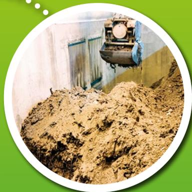
Bei einer Verbrennung bleibt immer Asche übrig. Die Asche vom Müllheizkraftwerk wird Schlacke genannt. Diese Schlacke fällt in den **Schlackebunker**. Hier kühlt sie aus.
